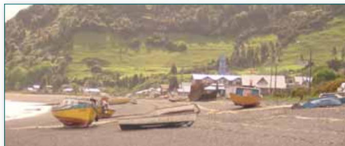
Vista de Tenaún desde la playa, de este a oeste. Al fondo se divisa la torre de la Iglesia.
