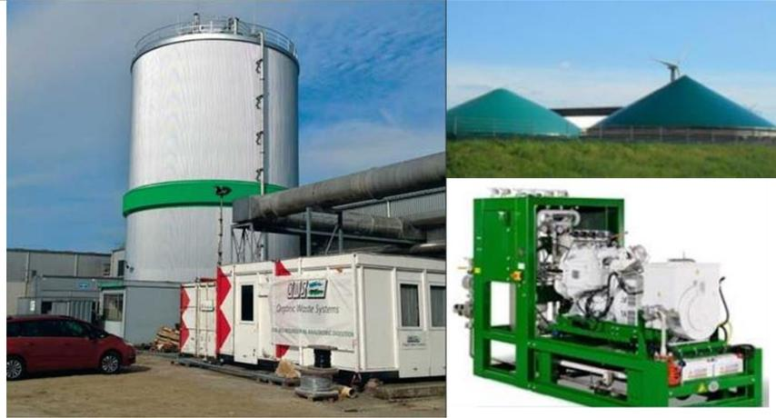
Planta de Digestión Anaerobia. En la imagen a la izquierda se puede apreciar la planta de Digestión Anaerobia. En la imagen superior derecha se puede apreciar el gasómetro de doble capa sobre el digestor y en la imagen inferior derecha, se puede apreciar el motor de cogeneración de energía eléctrica y térmica.
