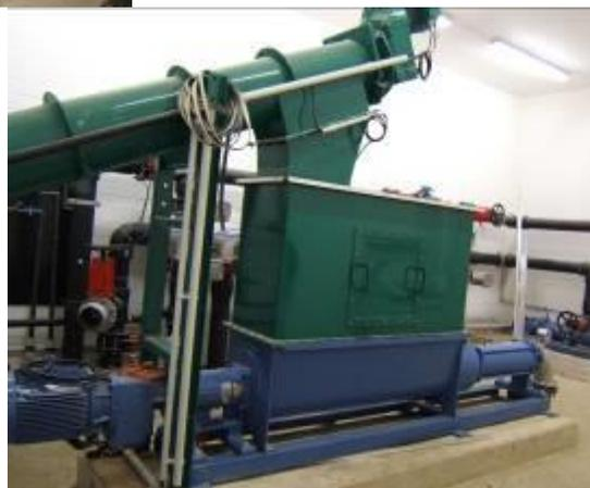
Figura 8-1: Picador rotatorio en tubería de transporte de sustrato (imagen superior). Mezcladores de Substratos fluidos y fibrosos: Mezclador con Picador y bomba de paletas rotatorias (inferior izquierda) y Mezclador con bomba de cavidad progresiva (inferior derecha).
