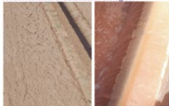
Lodo y agua clarificada. Nestlé D'Onofrio Lima 100 m 3 /h.
