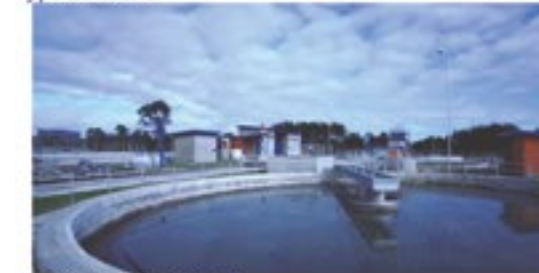
PTAS Villarrica 1.000 m 3 /h.
